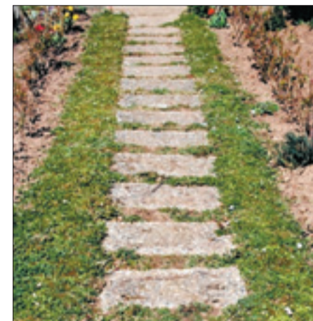
Locker verlegte Platten statt versiegelter Fläche.
